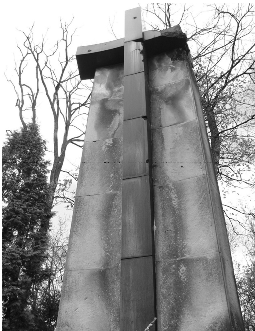
3. Pomnik – ołtarz, na ramieniu krzyża widoczne ślady zniszczeń z 1939 r. (stan z 2003 r., fot. Agnieszka Stachnik).
