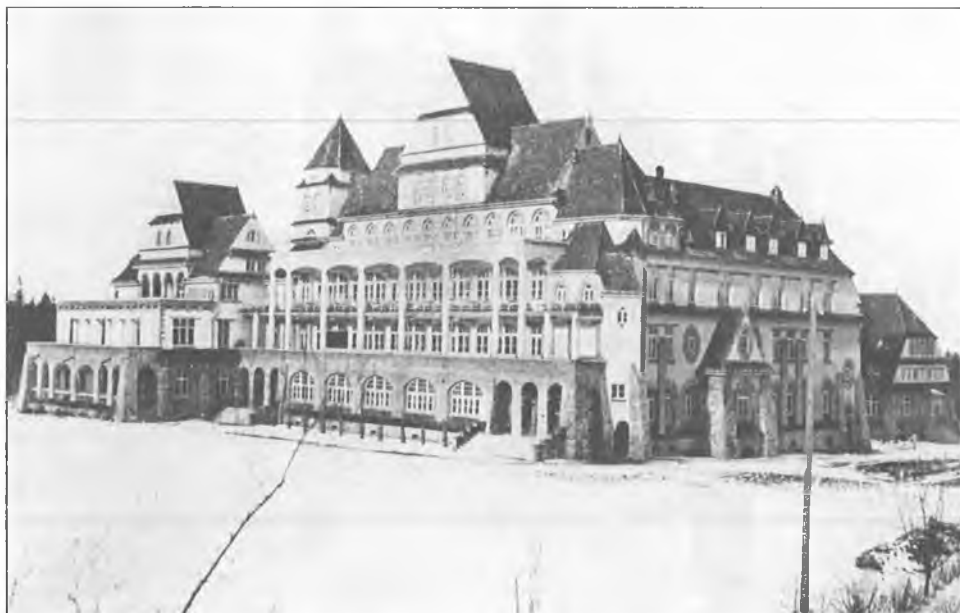
Sanatorium przeciwgruźlicze dla dzieci, zbudowane staraniem K. B. K. w Zakopanem (Fot. wg „Jubileuszowej księgi pamiątkowej – 25-lat pasterzowania Metropolity Adama Stefana Sapiehy”. Kraków 1937).
