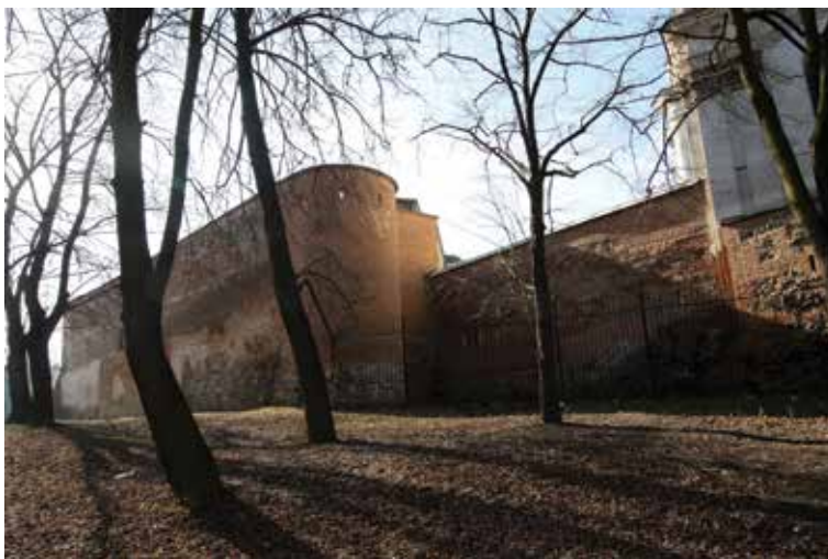
7. Półbastion w systemie nowowłoskim, front północno-wschodni obwarowań, widok od północy, 6.03.2015. Fot. Adam Sapeta
