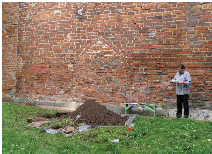
il. 7. Zamurowany otwór wejściowy w północnej elewacji nawy
