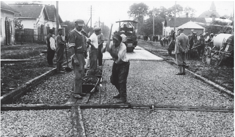
Fot. 8. Robotnicy przy budowie dróg, ulica Sapieżyńska. Po prawej stronie wałowanie powierzchni asfaltowej. W 1930 r. gmina Stanisławów podpisała umowę z firmą Trwałe Drogi, która specjalizowała się w Polsce w wykonywaniu dróg systemem „Warenite Bitulithic” (Narodowe Archiwum Cyfrowe)
