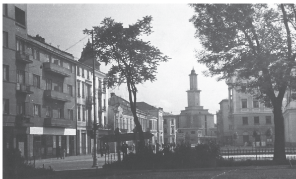
Fot. 5. Stanisławów w II Rzeczypospolitej – nowy wygląd ulicy Franciszka Karpińskiego. Od lewej: powstałe po odbudowie miasta modernistyczne kamienice, wieże katedry greckokatolickiej z barokowymi hełmami, które zostały umieszczone w miejsce dawnych, przebudowany ratusz. Fot. Marian Jędryk, lata 30. XX w. (kolekcja Tomasza Jędryka)
