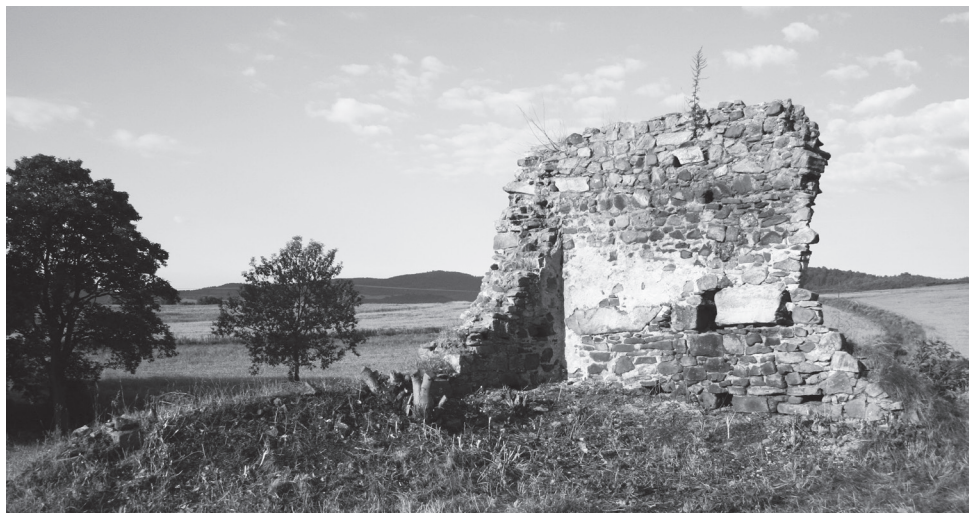
Ryc. 7. Sędziszowa. Południowo-zachodni narożnik kościoła z widocznymi fragmentami wyprawy tynkarskiej (fot. A. Szyber).
