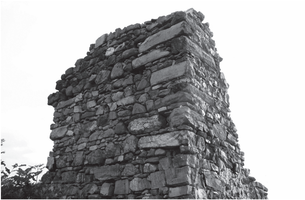
Ryc. 4. Sędziszowa. Południowo-zachodni narożnik kościoła z widocznymi ciosami kamiennymi w narożnikach (fot. A. Szyber).
