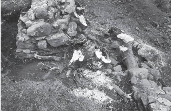
Ryc. 9. Sędziszowa, wykop 10/2010. Miejsce przejścia nawy w prezbiterium – widok od zachodu (fot. A. Szyber).
