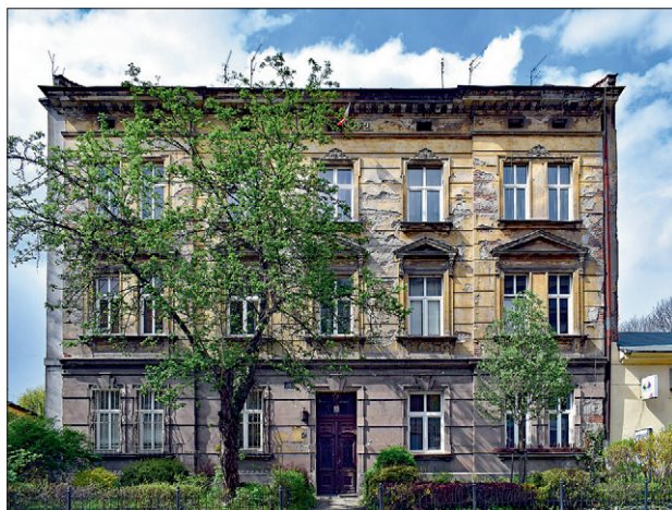
Fotografia 3. Kraków — dom przy ulicy Garbarskiej 13
