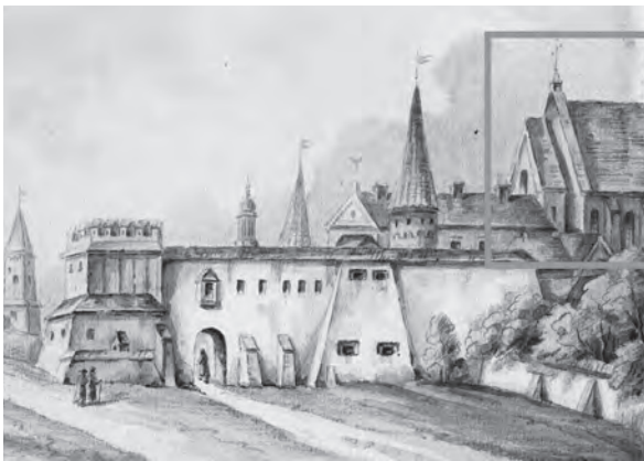
Ryc. 5. Wygląd krakowskiego kościoła św. Szczepana wraz z widocznymi przyporami ściany południowej po XVII-wiecznej jezuitckiej przebudowie na akwareli Jana Kantego Wojnarowskiego z widokiem Bramy Szewskiej (przed 1840 r.) ze zbiorów Muzeum Krakowa (nr inw. MHK-1068/VIII). Repr. za. http://ct.mhk.pl/wps/portal/mhmk/main/strona-artefaktu/?artefactId={55C27899-A622-4C61-8149-C54078C2AED3} (dostęp: 5.12.2022 r.).
