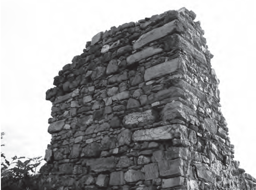
Ryc. 4. Sędziszowa. Południowo-zachodni narożnik kościoła z widocznymi ciosami kamiennymi w narożnikach (fot. A. Szyber).
