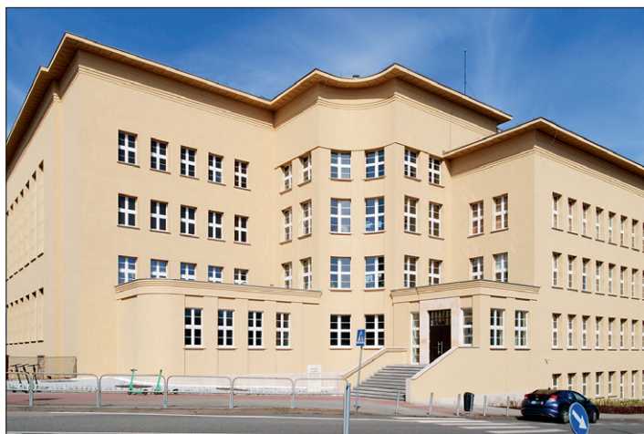
Fotografia 10. Gmach Wyższego Śląskiego Seminarium Duchownego w Katowicach po modernizacji
