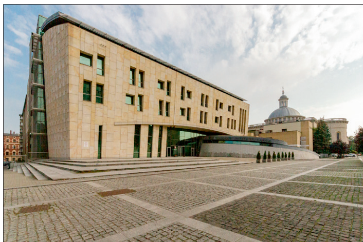
Fotografia 11. Budynek Wydziału Teologicznego Uniwersytetu Śląskiego w przestrzeni Placu Prymasa Hłonda
