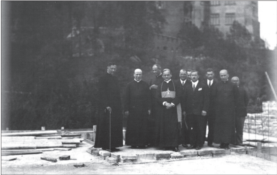
Fotografia 1. Biskup Teodor Kubina wraz z Radą Diecezjalną na placu budowy seminarium
